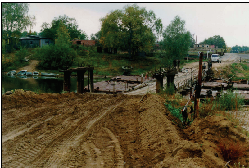
Foto 6: Die alte Pontonbrücke über die Sosch (vor 2003)
