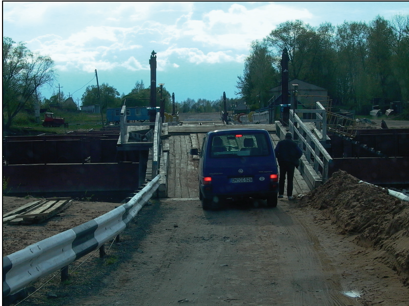
Foto 5: Neue Pontonbrücke über die Sosch auf der Strecke von Korma nach Volincy (2005)
